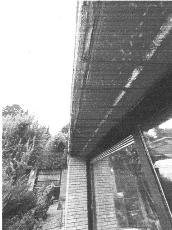
Erheblicher Feuchtigkeitseintrag direkt unterhalb der Attika
