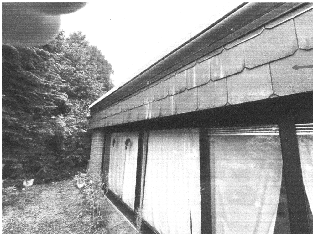
Erheblicher Feuchtigkeitseintrag direkt unterhalb der Attika
