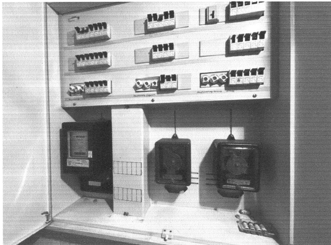
Technisch überalterte Elektrounterverteilung
